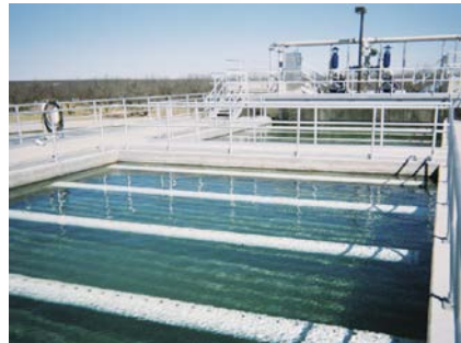
รูปที่ 2. ถังตกตะกอนแบบควบคุมชั้นตะกอน (superpulser) (Degremont Technologies, 2018)
